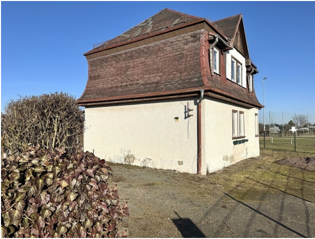
Blick von Zufahrt
