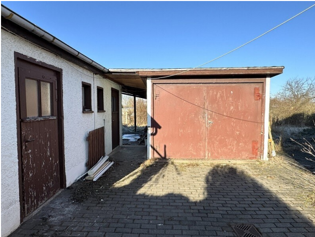
Garage und Nebengelass
